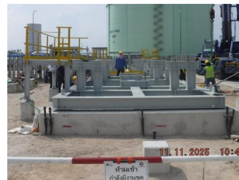
งานติดตั้งโครงสร้างและรองรับอุปกรณ์
